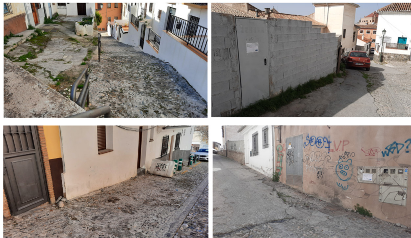
Imágenes de las áreas de intervención en el Bajo Albaicín.
